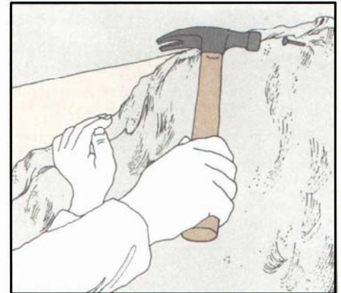
1. Zaag staanders en regels op de juiste lengte, pas ze in en merk ze. Bevestig nu de eerste deken met stalen spijkers in de muur. Trek de deken niet te strak (ruimvallend).
